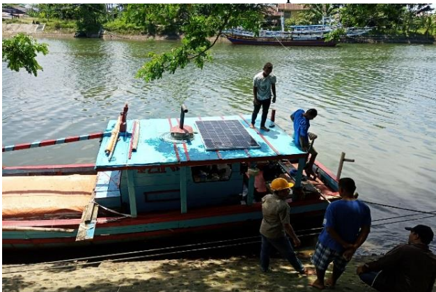
Gambar 5. Pemasangan solar cell di kapal nelayan
